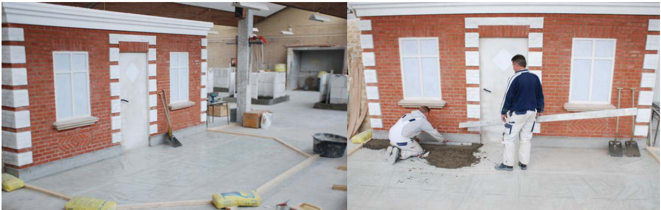
Forarbejde til gulv
