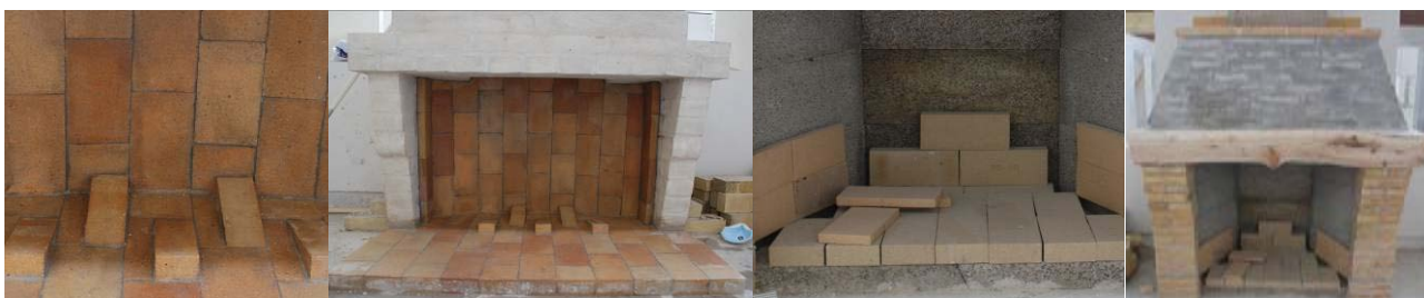
Pejs muret efter Rumfordprincippet
